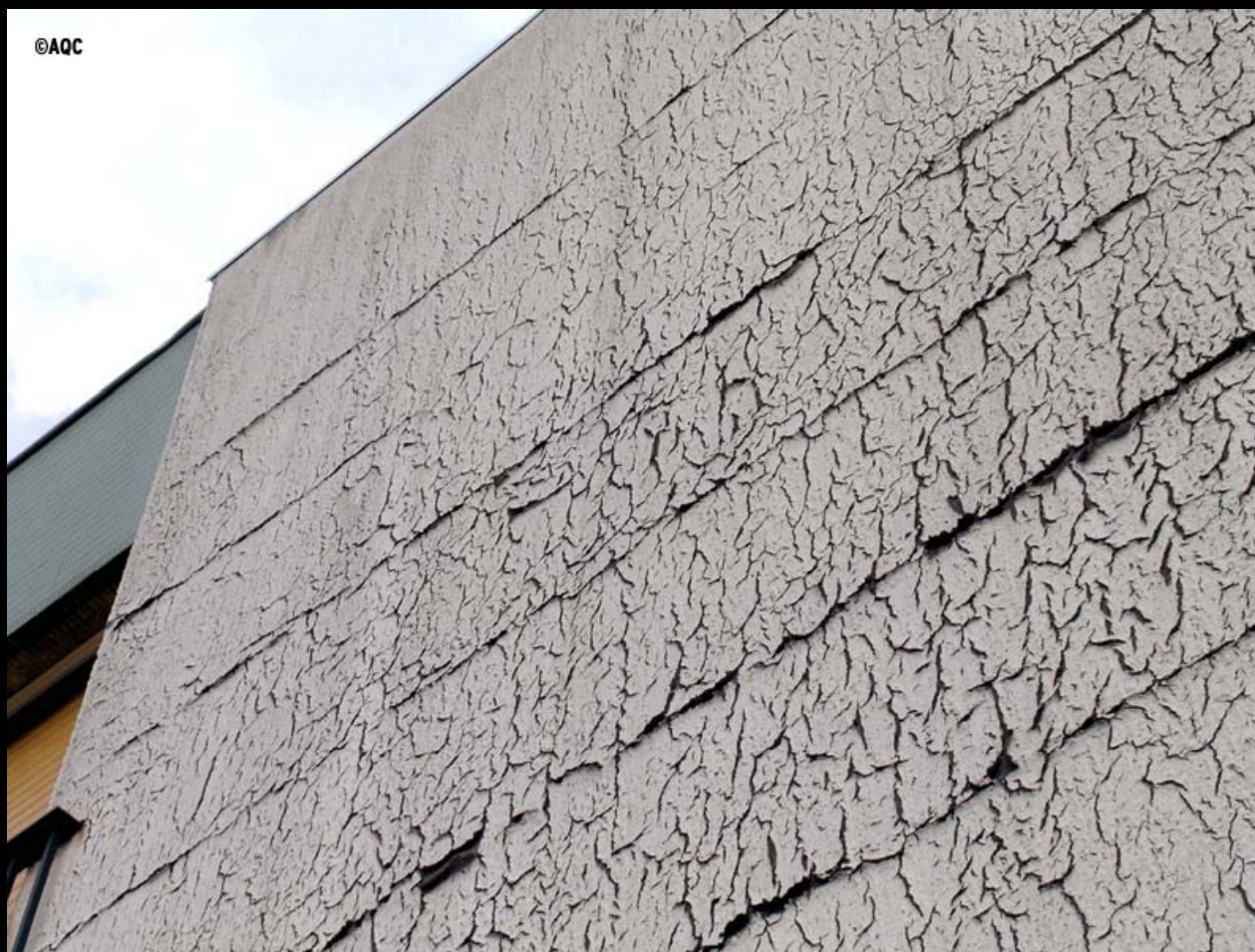
ITE avec enduit finition RPE sur isolant alvéolaire
